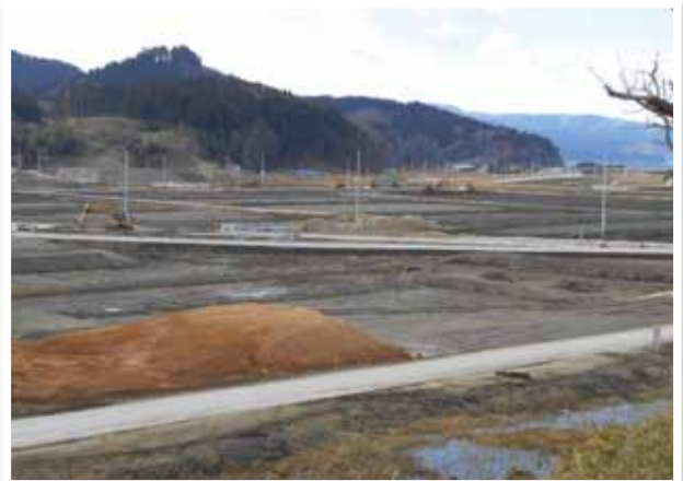
工事中 平成26年1月
