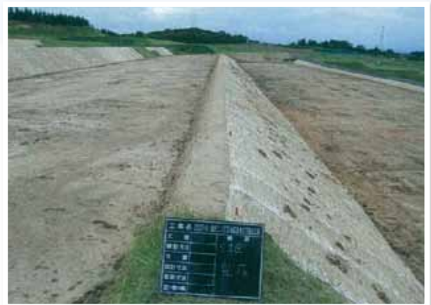
復旧後 平成24年7月
