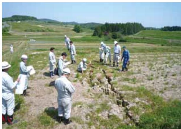
奥州市江刺区(水田の亀裂)
