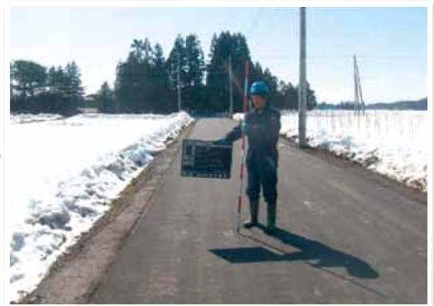
復旧後 平成24年3月
