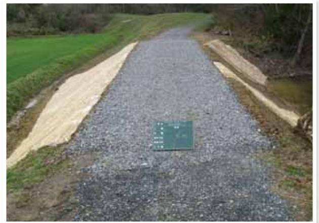
復旧後 平成24年5月
