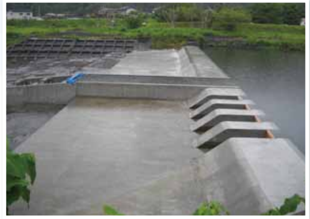
復旧後 平成25年5月
