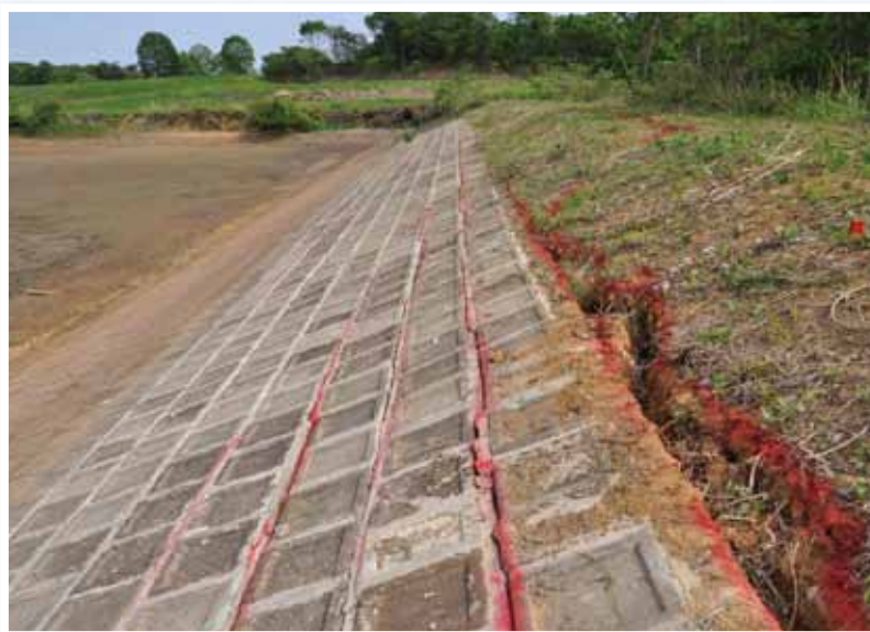
堤体法面の滑り、堤体の亀裂
