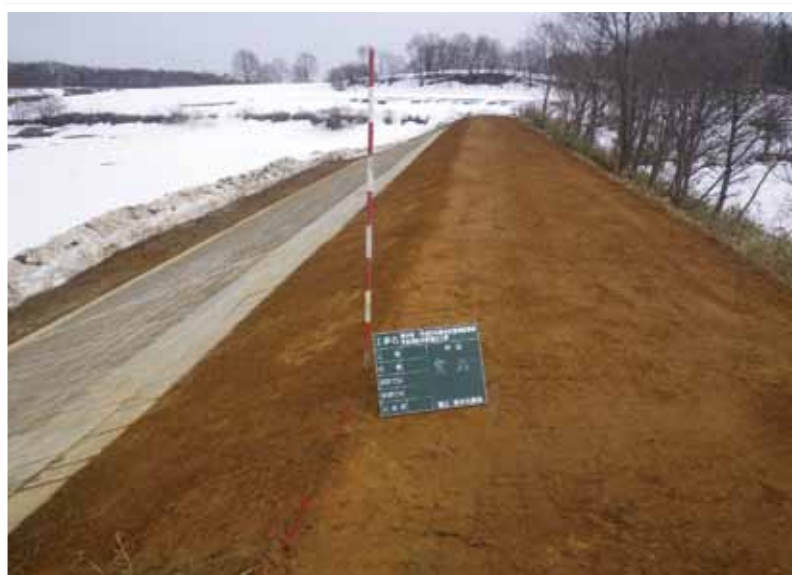
復旧後 平成24年3月
