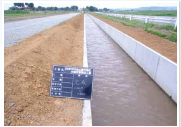
復旧後 平成24年3月
