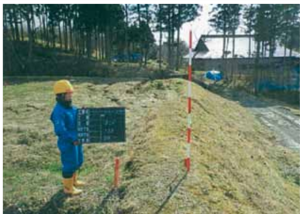
田の亀裂と畦畔の崩落
