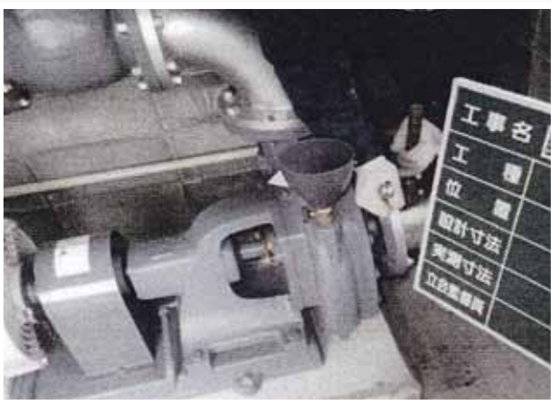
建屋及び電気設備、配管の復旧状況
