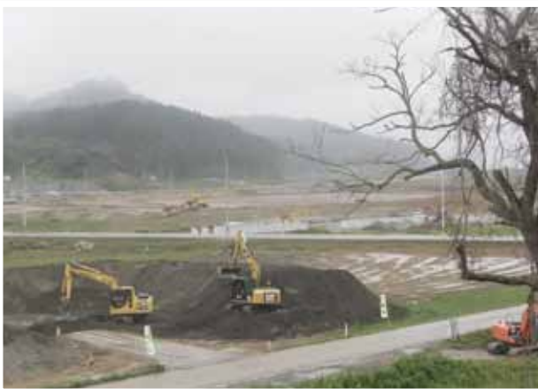
工事中 基盤土の搬入、敷き均し 平成25年9月
