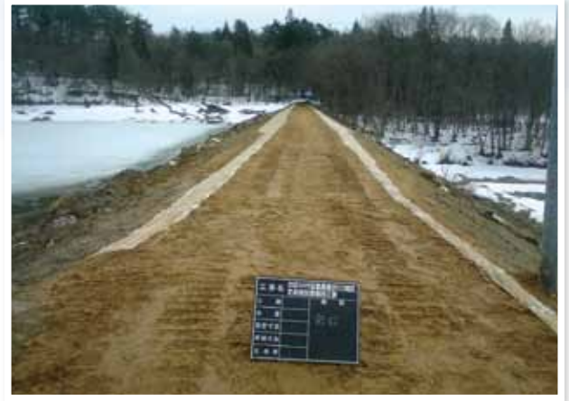
復旧後 平成24年3月
