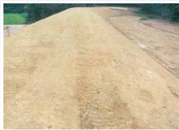
復旧後 平成25年2月
