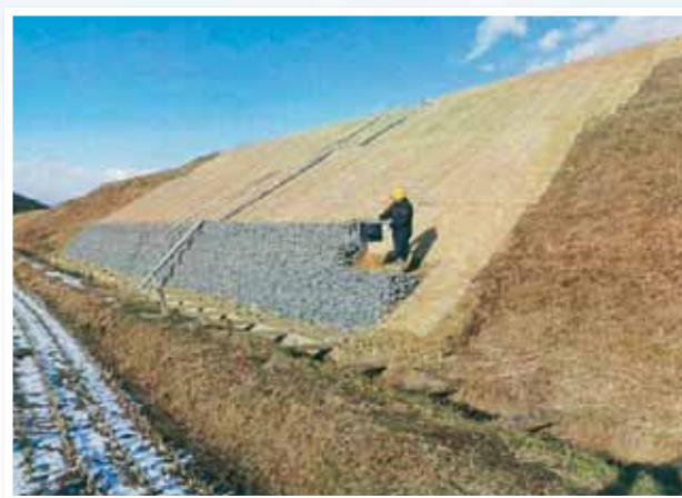
復旧後 平成24年12月
