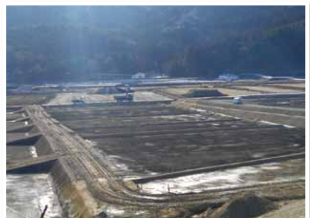
平成26年春の作付けを目指して工事中 平成26年1月
