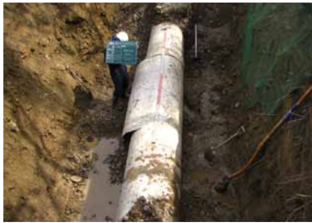
北上市和賀町(幹線パイプライン接合部の破損)
