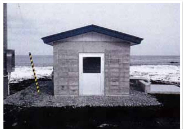
復旧後 平成24年2月
