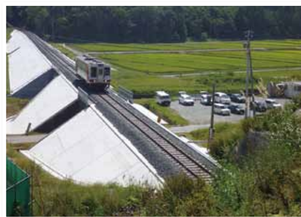
復旧後 平成24年9月
