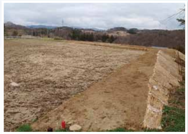
復旧後 平成24年4月
