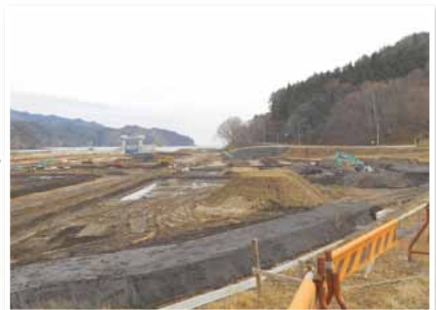
平成26年春の作付けを目指して工事中 平成25年12月
