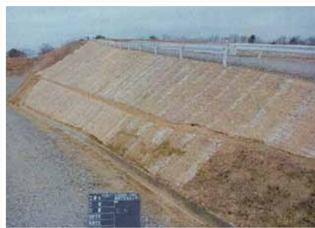
復旧後 平成25年3月
