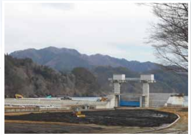
海岸堤防工事中 平成26年1月
