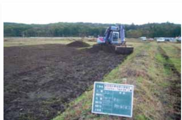
堆積土砂の撤去
