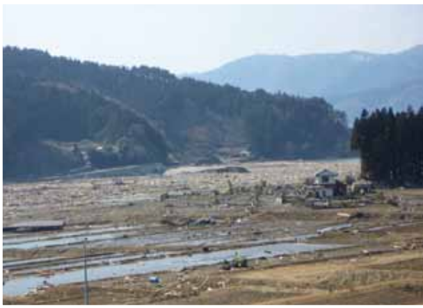
被災状況 平成23年4月
