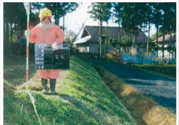
復旧後 平成24年12月
