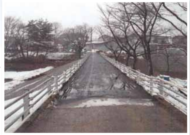
復旧後 平成24年3月
