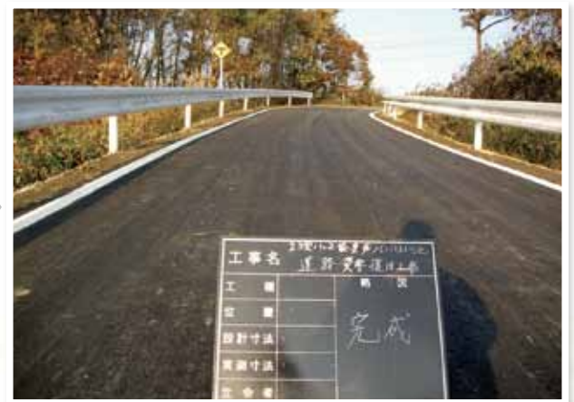
復旧後 平成23年12月
