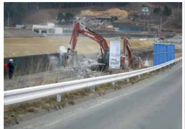
工事中 平成26年1月
