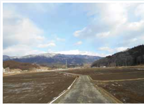
平成26年春の作付けを目指して工事中
