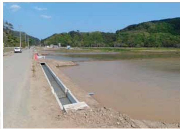
復旧後 平成25年4月
