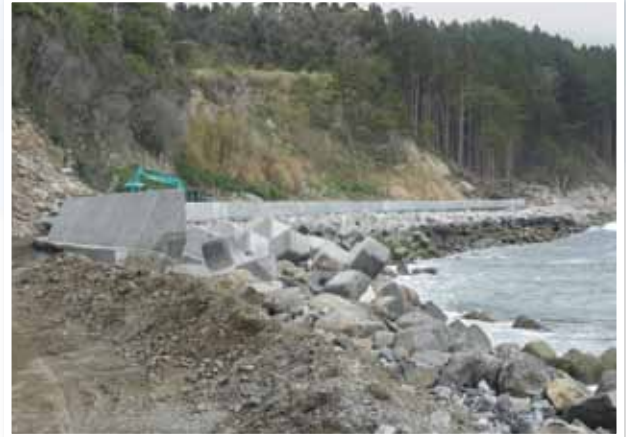
復旧後 平成24年5月
