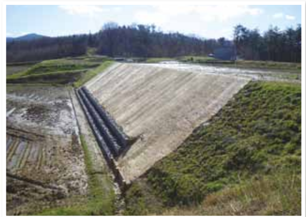
復旧後 平成24年4月
