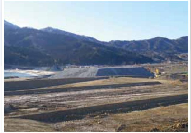
海岸堤防築堤工事中 平成26年1月
