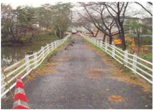
堤頂の亀裂
