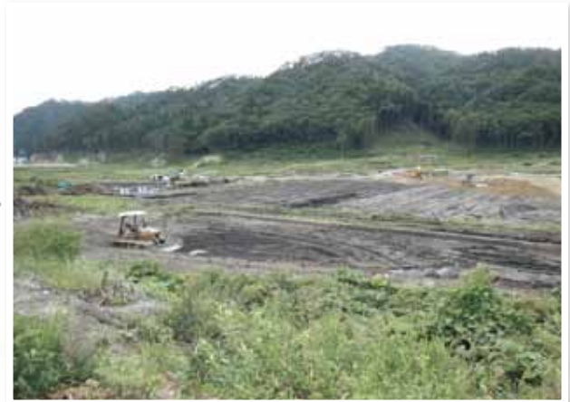
平成26年春の作付けを目指して工事中 平成25年9月
