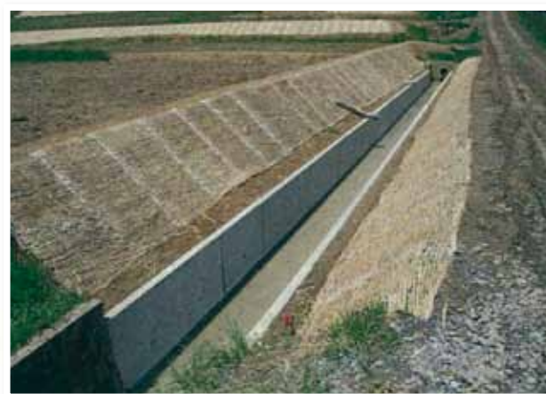
復旧後 平成24年6月
