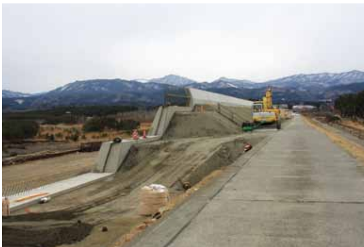
海岸高潮対策事業で施工中の農地海岸保全施設（堤防）
