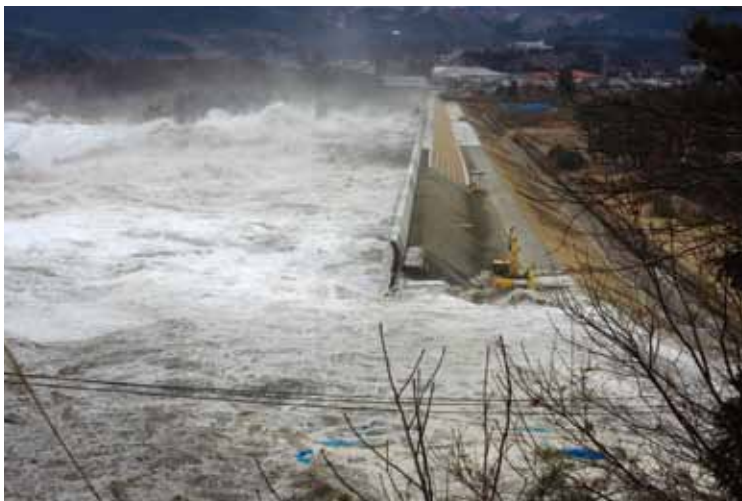
津波が工事区間を越流 (午後3時34分)
