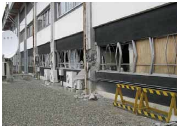
震災直後の遠野市役所庁舎（柱の崩壊や窓枠が折れている）
