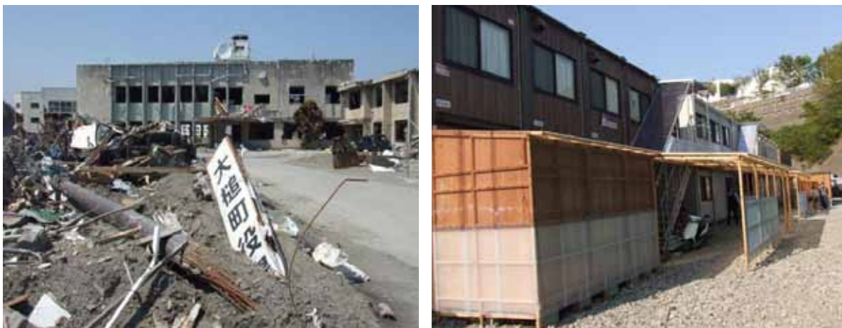
全壊した大槌町役場と仮庁舎
