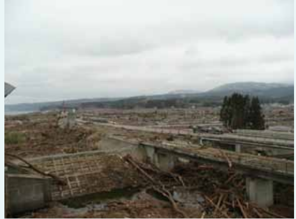
三陸鉄道と国道45号の被害状況 (出典：農村振興いわて 2013.1号)
