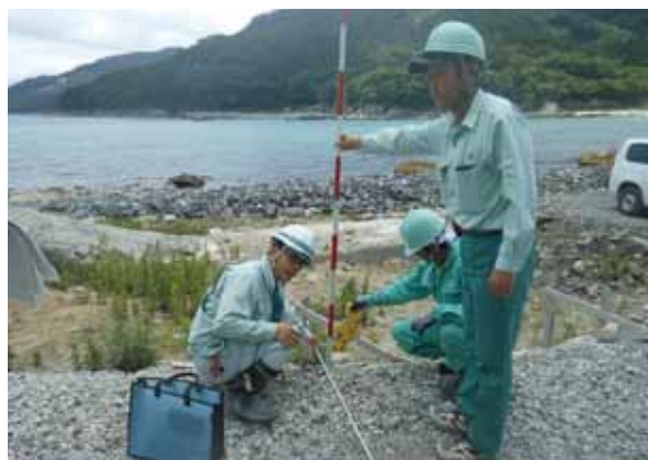
沖田地区海岸保全施設（大船渡市）での計測
