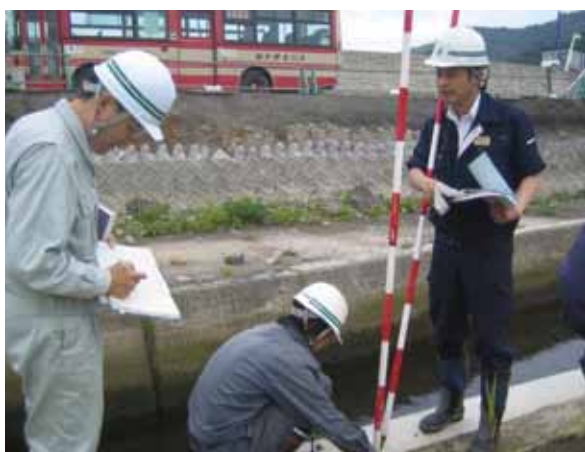
大浦地区（山田町）の工事完成検査
