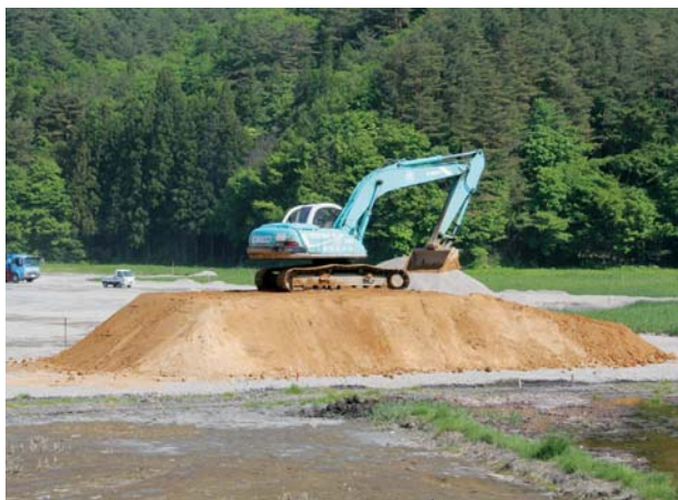
ほ場整備地区に搬入される「かさ上げ土」
