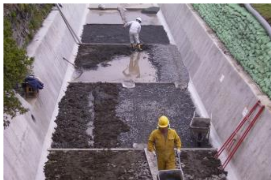
環境配慮対策施工状況
