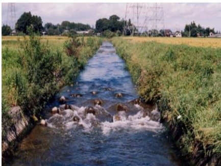
整備後の状況（急勾配側の左岸は流れが速く流量が多い、緩勾配側の右岸は水深が浅くなっている）
