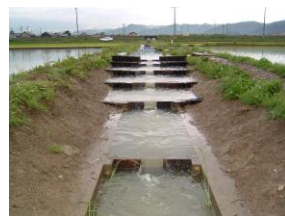
排水路堰上げ式水田魚道
