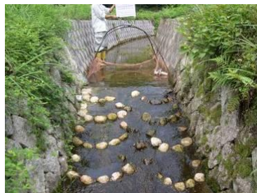
粗石付斜路型魚道の魚類遡上調査
