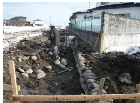
石積み水路の改修
