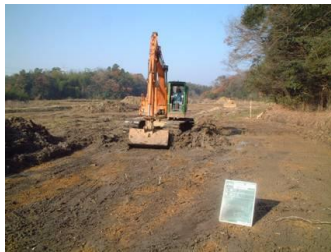
現況表土埋め戻しまでを実施
