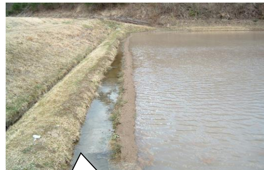
小水路の設置状況
