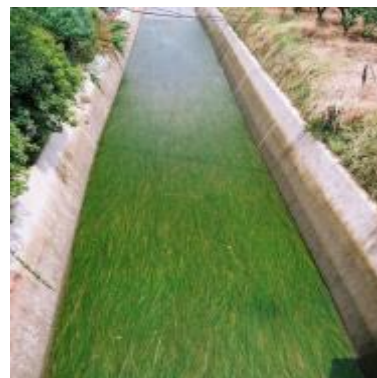
配慮対策施工後の水路
