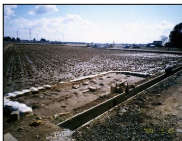
水田を借り入れ沈砂池として利用
