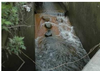
改良された魚道（片斜式粗石付魚道）
