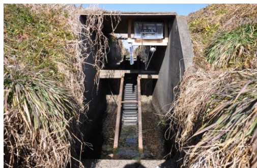
移動障害解消のため、追加整備された水路魚道
