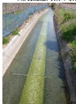
環境配慮対策改善後の水路
