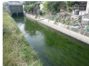
環境配慮対策実施後の水路
