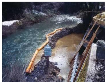
濁水防止フェンスによる抑制
