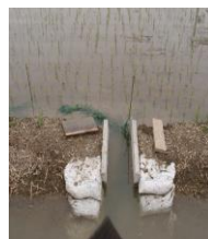
水路と水田との接続部
