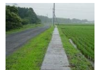
蓋が設置された水路
