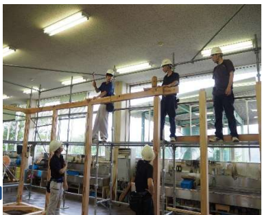
足場を組んで建方の勉強をします
