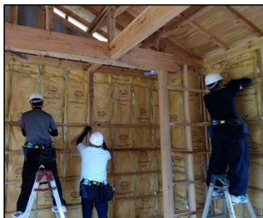
内部工事も行います
