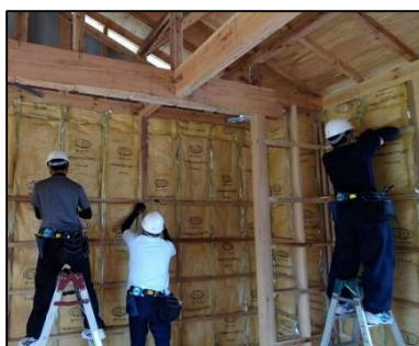
内部工事も行います
