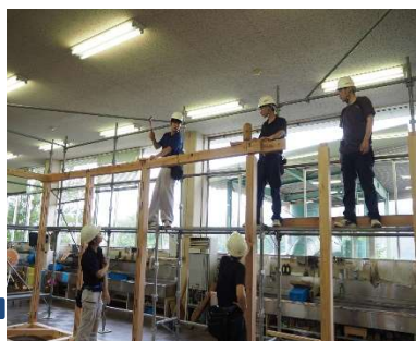
足場を組んで建方の勉強をします
