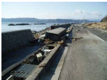
久慈港半崎地区（離岸堤）
