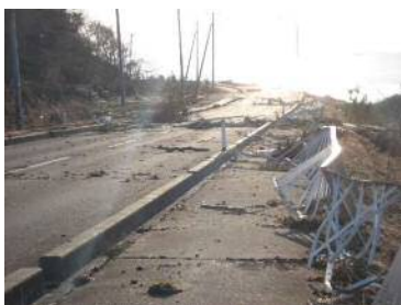
久慈港半崎地区（臨港道路）
