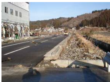
久慈港半崎地区（臨港道路）
