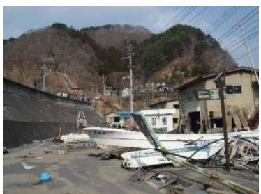
防潮堤前面の被災状況
