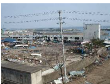
水門より下流側の被災状況
