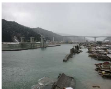
織笠川建設中水門残存状況
