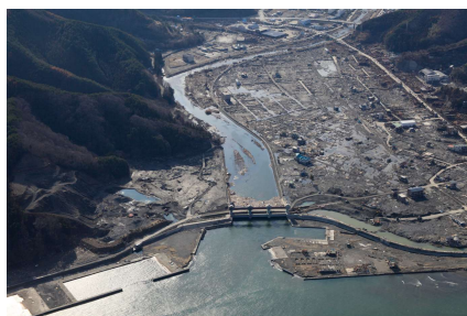
被災後の状況
