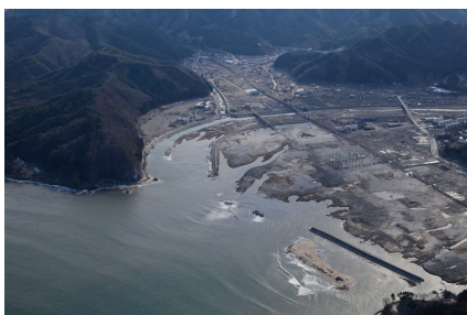
被災後の状況
