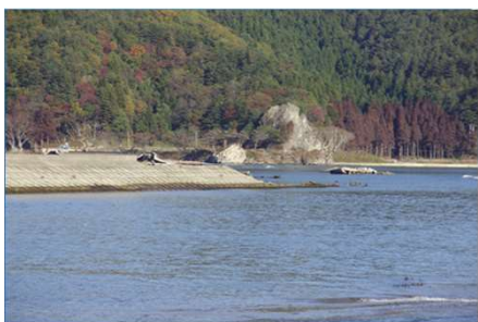
鵜住居川破堤状況
