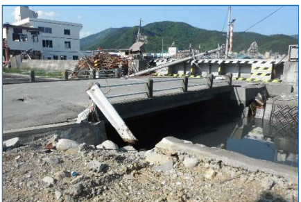
茶屋前地区旧陸閘
