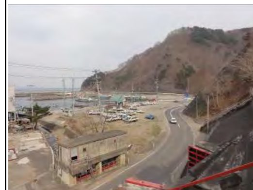
漁港施設内の建物には損傷は見られるが、全壊していないものも多数あり、他地域に比べて到達した津波の高さや破壊力は小さかったものと考えられる。
