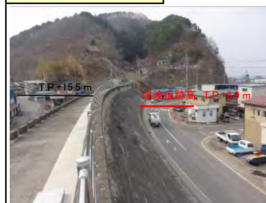
高さT.P.+15.5mの防潮堤は表・裏ともに損壊がなく、津波が越流した形跡はない。背後地の家屋にも全く被害は出ていない。
