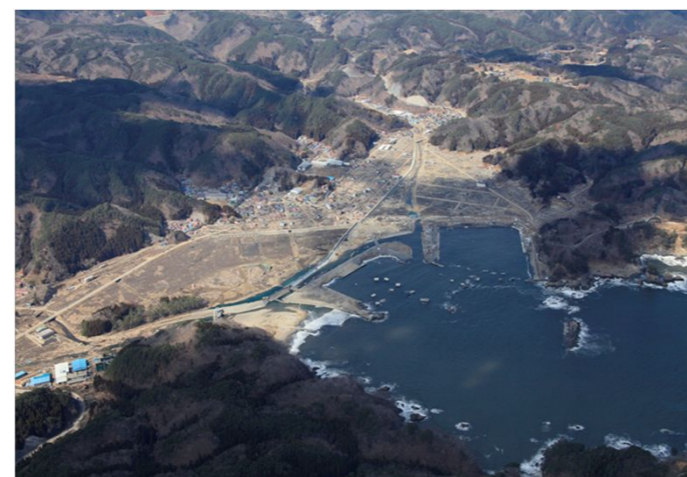
被災後状況 H23.3.28撮影
