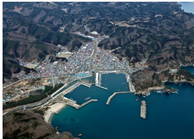
被災前状況 H22.3.10撮影
