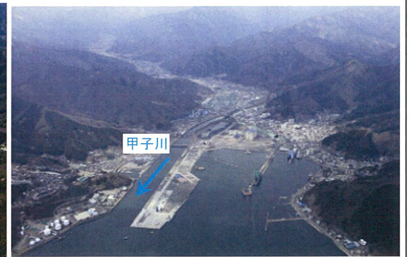
被災後状況 H23.3.29 撮影
