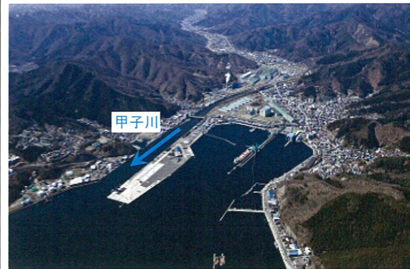
被災前状況 H22.3.19 撮影
