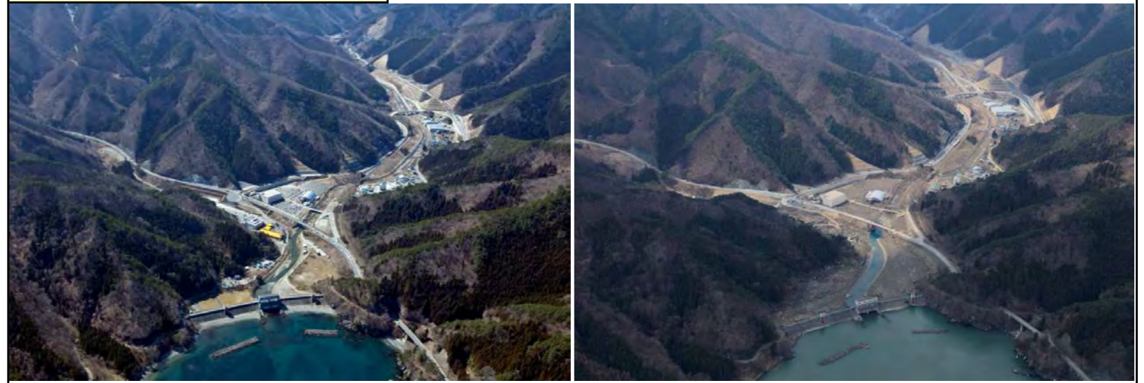
被災前状況 H22.3.19 撮影
