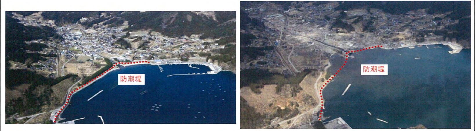
被災前状況 H22.3.14 撮影
