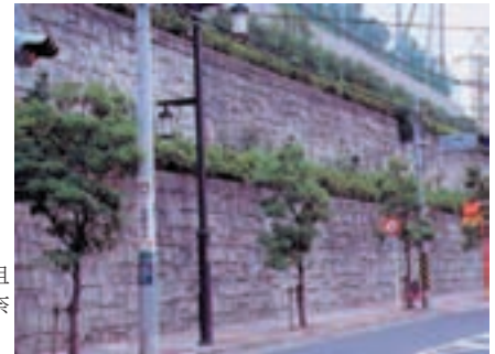
○ 長大な擁壁を分割するとともに、植栽と組み合わせることで圧迫感を軽減している。(神奈川県小田原市)
