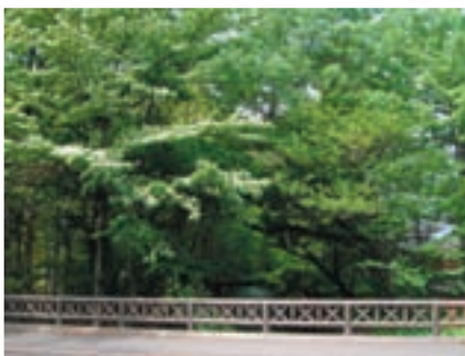
○コンクリート製の擬木高欄が、背後の緑に調和している。(東京都昭島市・玉川上水)
