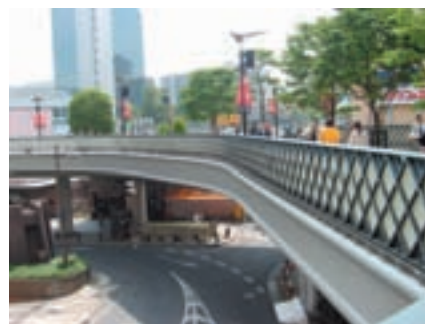
○高欄に地域の産業である鋳物を用いて、特徴あるデザインを施している。(埼玉県川口市・JR川口駅前)
