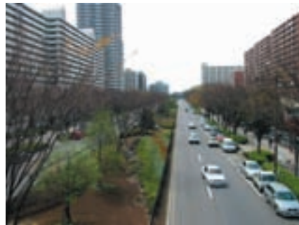
○幅広い分離帯を設け、直線的な道路に変化をもたせている。（東京都練馬区・光が丘団地）
