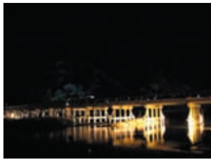
○橋脚部への控えめな照明により、幻想的な夜間景観を創出している。(京都府京都市・渡月橋)
