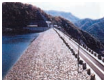
○石を積み上げたロックフィルダムが壮大な自然景観と調和している。(群馬県みなかみ町・奈良俣ダム)
