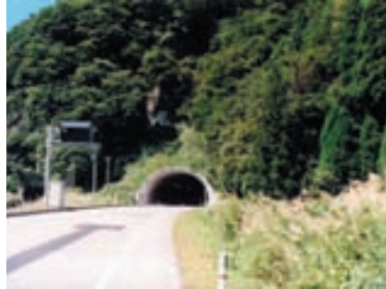
○出入口周辺を緑化し、周囲の緑との調和を図っている。(富山県立山町・千垣トンネル)
