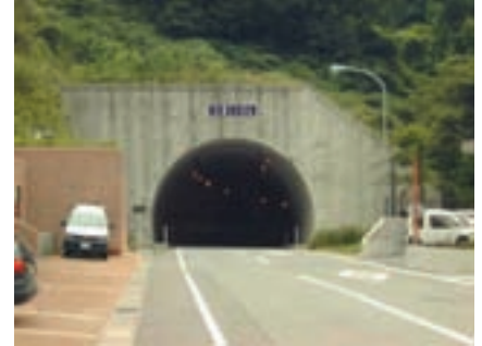
○自然石風の仕上げにより、周囲の自然景観との違和感を軽減している。(富山県黒部市・大原トンネル)
