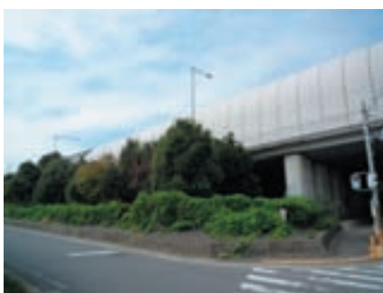
○遮音壁に曲線を用いるとともに、高架下に植栽を施し、圧迫感を軽減している。(神奈川県秦野市・東名高速道路)
