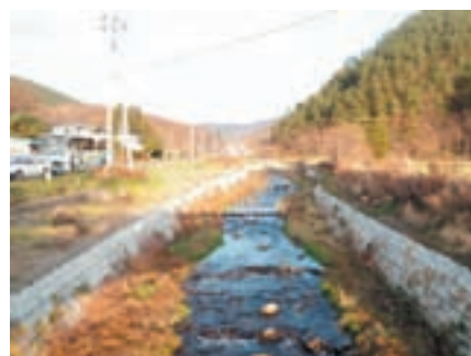
○落差工に自然石を用いて、生態系に配慮したデザインとしている。(岩手県葛巻町・元町川)
