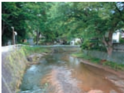
○石積み護岸により、構造物の印象を和らげている。(岩手県一関市・千厩川)
