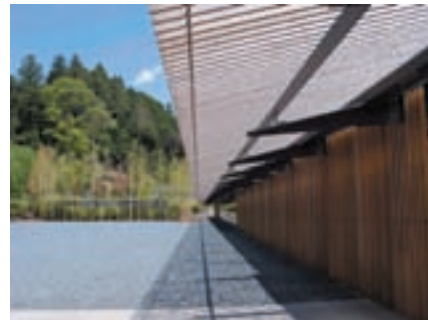
○ 建物全体を八溝杉の材で囲い、周辺の自然景観との調和に配慮している。(栃木県那珂川町・馬頭広重美術館)
