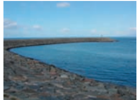
○突堤を自然石仕上げとし、眺望に配慮している。（富山県射水市・海老江）
