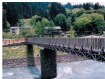
○石貼りの橋脚と木製の高欄等がまとまっており、自然地に違和感なくとけ込んでいる。(富山県南砺市)
