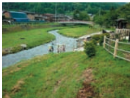
○堤防の緩傾斜化や階段の設置により、親水性の高い空間としている。(岩手県遠野市・小友川)
