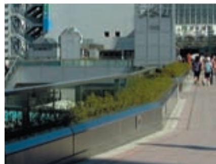
○ガラスと植栽を組み合わせ、ボリューム感を軽減している。(神奈川県茅ヶ崎市・JR茅ヶ崎駅前)
