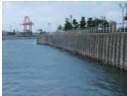
○コンクリート護岸に表面処理を施し、自然になじむよう配慮している。(富山県新湊市・海王丸パーク)
