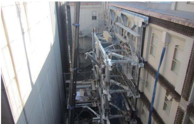
外部補強、鉄骨建方施工状況
