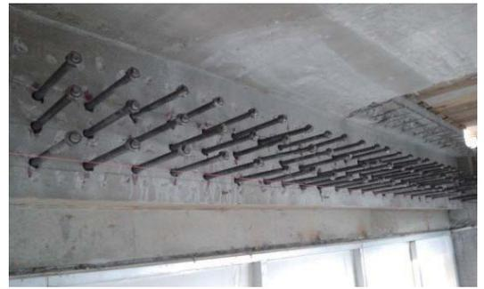
アンカー打設状況(水平ブレース)
