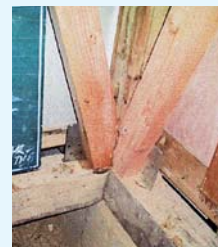
筋交、構造用合板の設置による壁の補強
