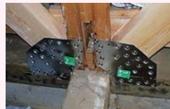
補強金物の設置
