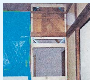
壁補強キット取付による壁の補強
