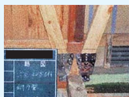
補強金物取付による壁の補強
