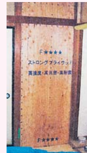
構造用合板の設置
