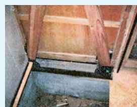
補強金物取付による壁の補強
