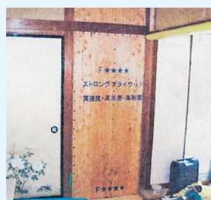
構造用合板取付による壁の補強
