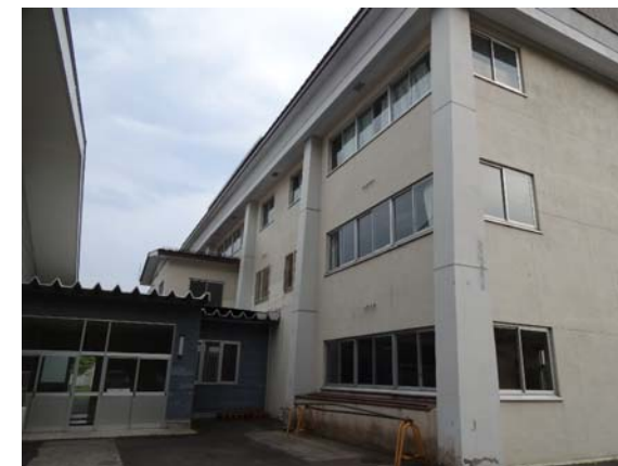
③ 既存校舎（管理・教室棟）
