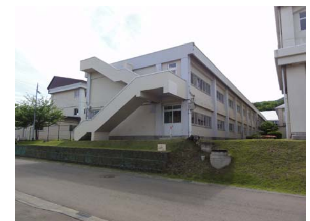
⑧ 既存校舎（電気情報システム科実習棟（南館））
