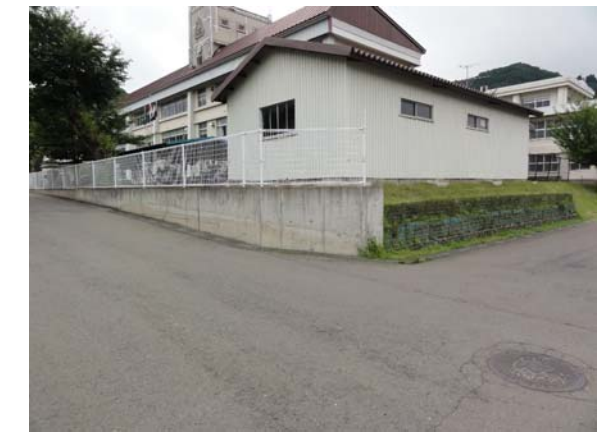
② 建設予定地（既存校舎等解体）
