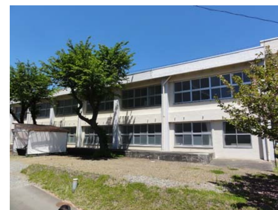
⑦ 既存校舎（電気情報システム科実習棟（南館））
