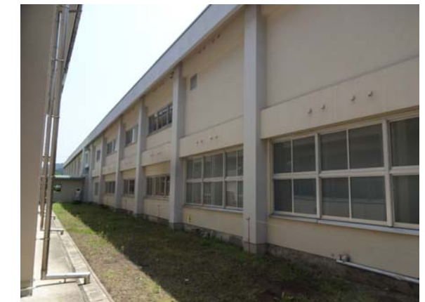
⑥ 既存校舎（電気情報システム科実習棟（南館））
