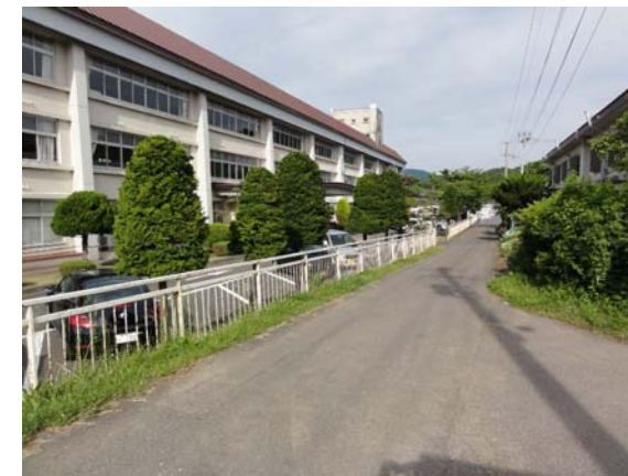
① 建設予定地（既存校舎等解体）
