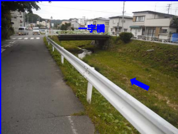
上流側から一字橋を見る
