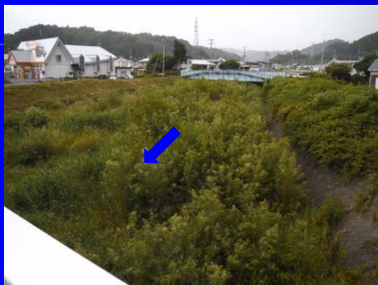
国道106号からJR橋を見る
