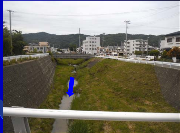
未改修区間下流端側より上流 JR橋を見る
