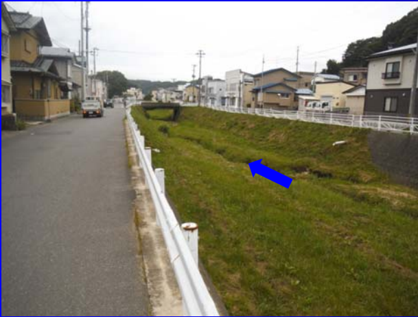
未改修区間上流端側より下流 山口橋を見る
