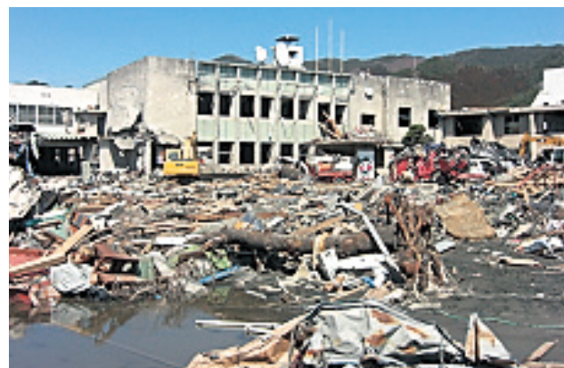
津波により壊滅した大槌町役場
