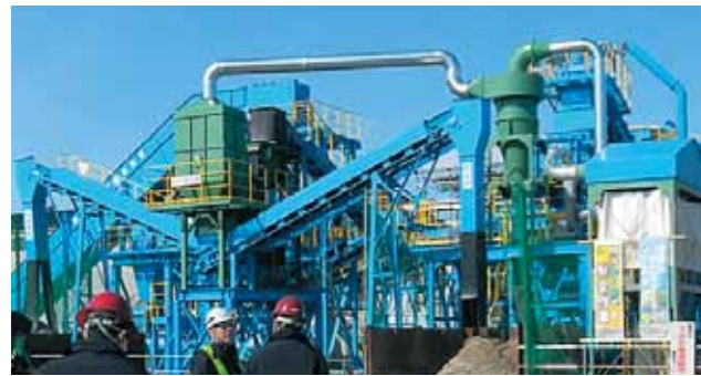
宮古市に設置した災害廃棄物の破碎・選別ライン
