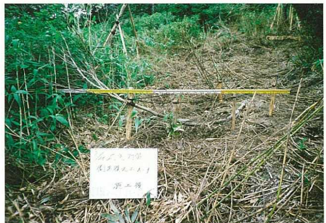
写真3-4 倒伏木復元工, 一本支柱 (応急対策)
