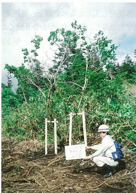
写真3-3 倒伏木復元工, 二脚鳥居 (応急対策)
