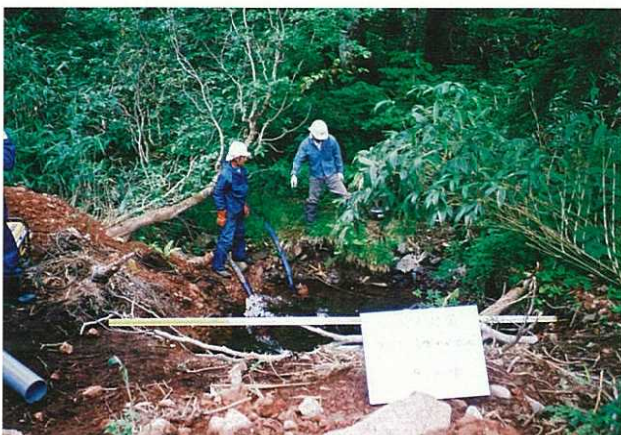
写真3-10 埋め戻し工（応急対策）
