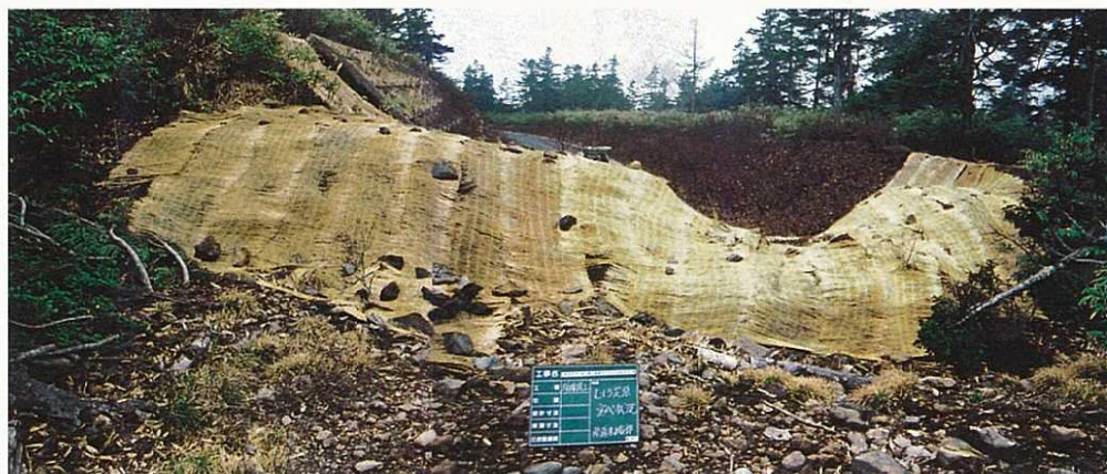
写真6-9 同上箇所のムシロ張・実播種試験を施工した直後の状況(2004年10月)
