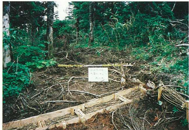
写真3-7 流水分散工・水路工（応急対策）
