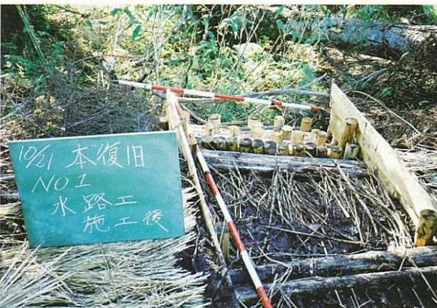
写真3-15 本復旧対策における水路工 (上：施行前，中：施行中，下：施行後)
