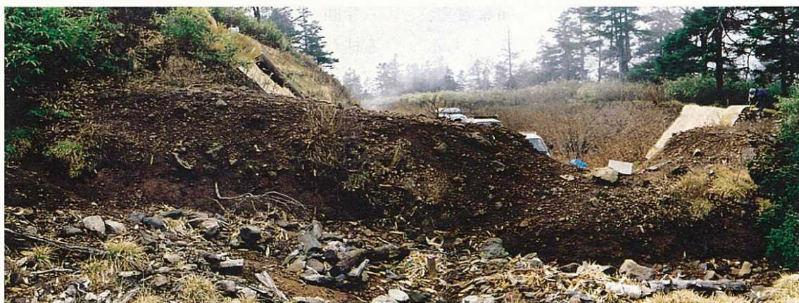
写真6-8 試験施工した網張側工事終点の状況(2004年10月)
