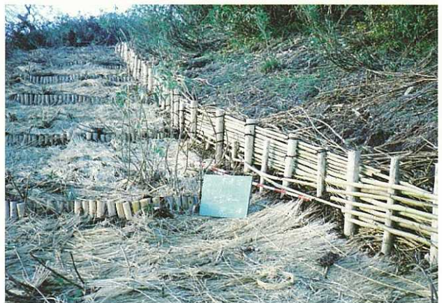
写真3-14 本復旧対策における土留柵工 (上：施行前，中：施行中，下：施行後)
