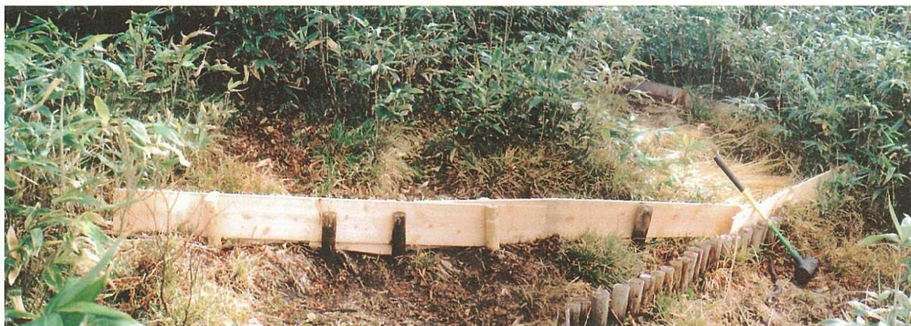
写真 7-5 片面板水路工
