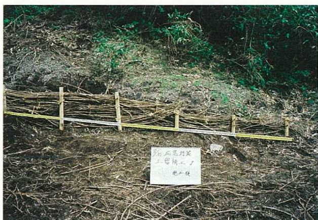
写真3-8 土留柵工（応急対策）
