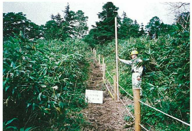
写真3-11 立ち入り防止柵設置工（応急対策）
