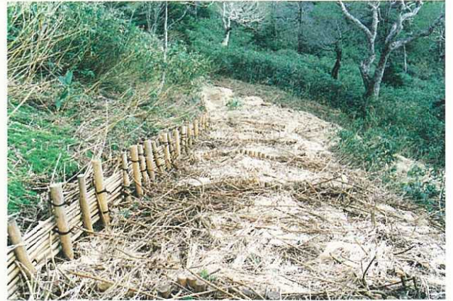
写真5-4 わら被覆工と土留工を施した1区北端部(1997年6月)
