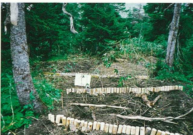
写真3-6 土留杭工（応急対策）
