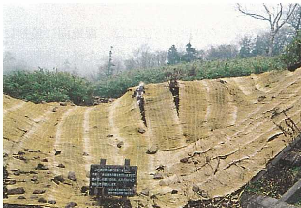
写真 6-15 裸地荒廃面を被覆するムシロ張工
