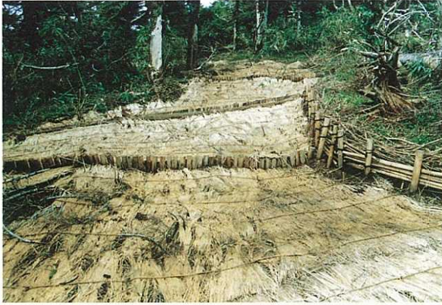
写真5-13 表土が削り取られた跡地にわら被覆工を施した4区南端部（1997年6月）
