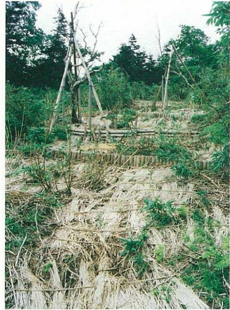
写真 5-10 わら被覆工を施した 3区南端部 (1997年6月)
