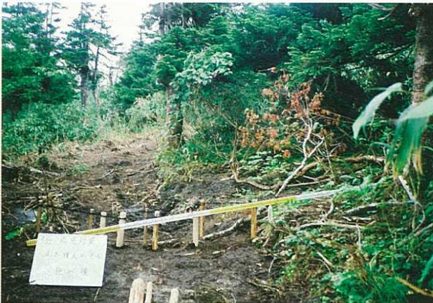
写真3-5 倒伏木復元工，根元保護（応急対策）
