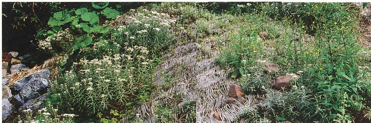
写真 6-16 緑化試験工の成績(網張側工事終点の現況: 2006年10月)
