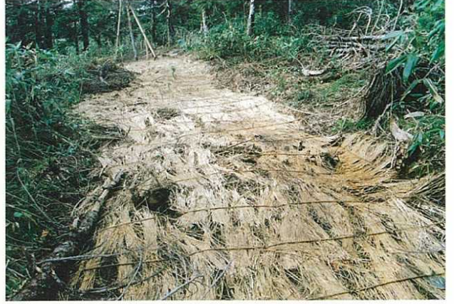
写真5-16 表土が深く削り取られた4区北端部（1997年6月）
