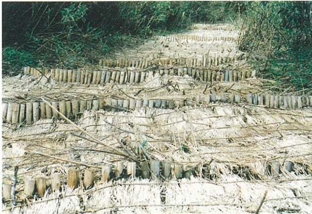
写真5-1 わら被覆工を施した1区南端部(1997年6月)
