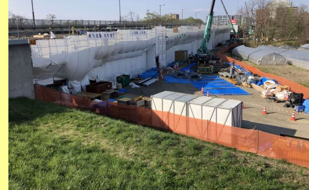
P6橋脚~A2橋台間
