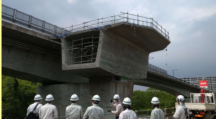
P3橋脚(柱頭部)
