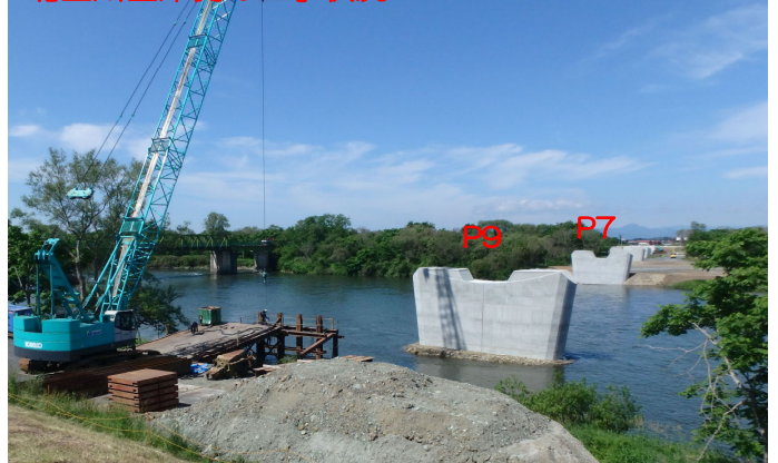
北上川左岸側の工事状況
