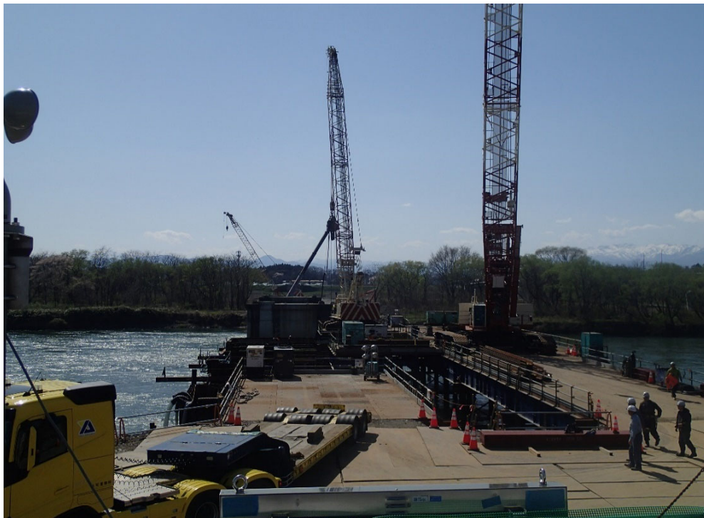
令和5年4月 小谷木橋下部工（P1～P4）撤去のための仮栈橋・仮締切設置
