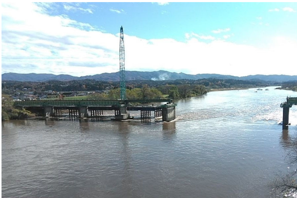
令和3年11月 小谷木橋上部工（鋼鈹桁）の吊り上げ撤去
