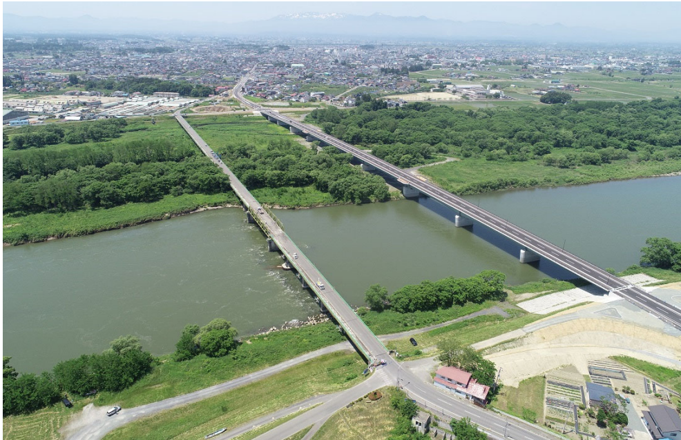
令和3年6月 新小谷木橋開通後の様子
