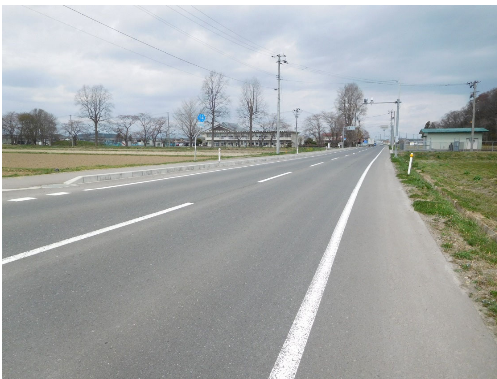
整備後（一部供用済区間）の状況
