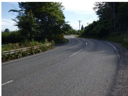
急カーブの状況①
