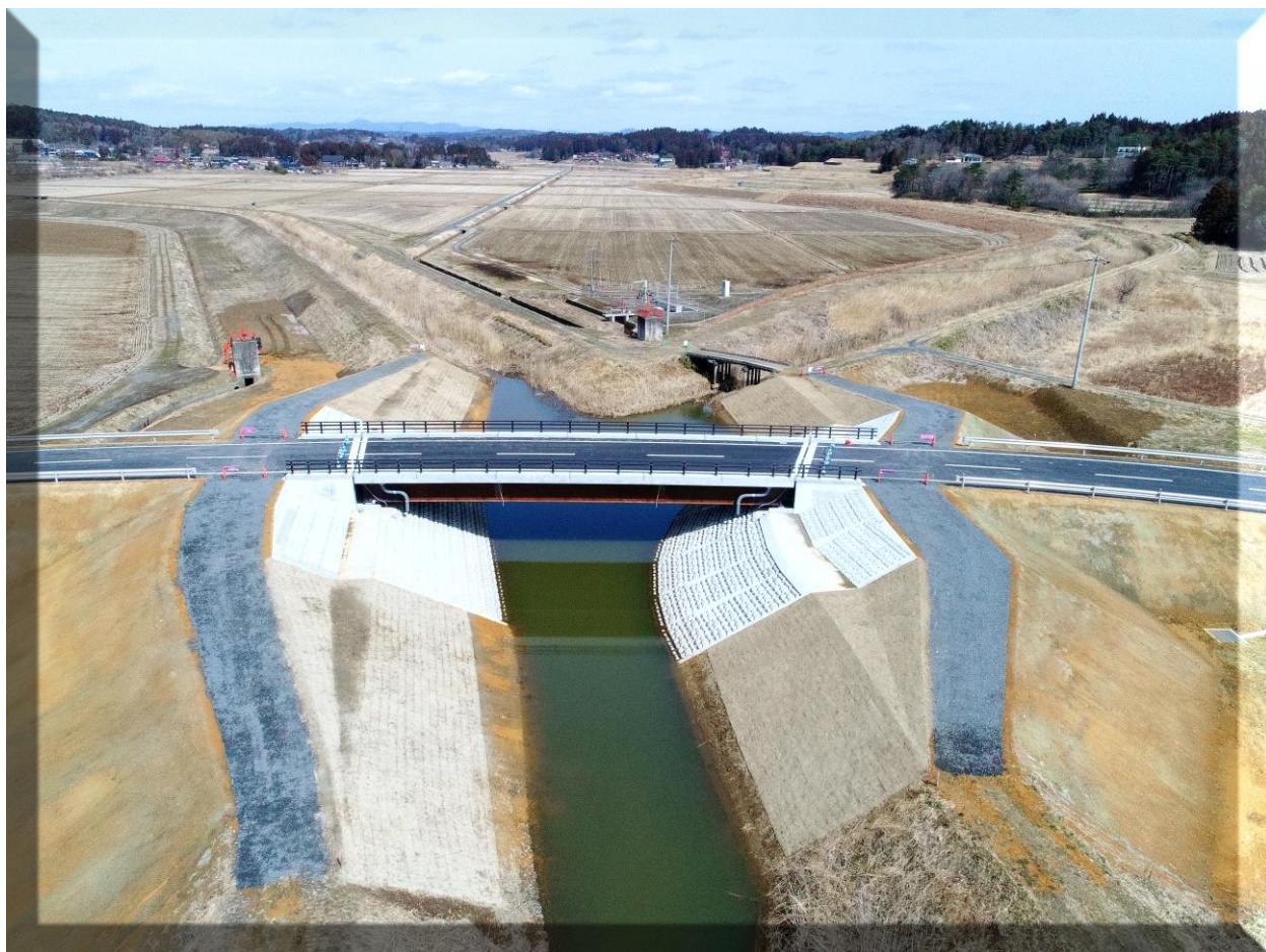
広域河川改修事業 藤の巻橋 (令和4年6月30日 完成)
