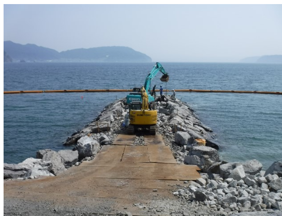
被覆石設置(陸上)
