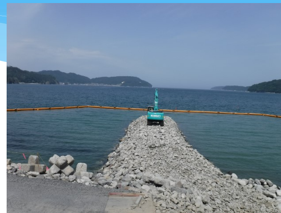
中詰石投入、均し
