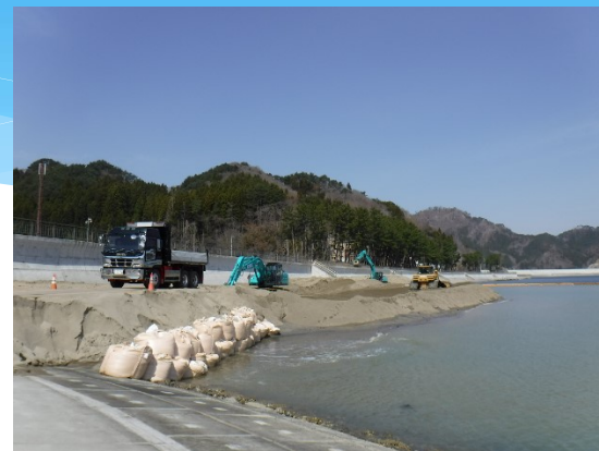
養浜砂搬入、敷き均し
