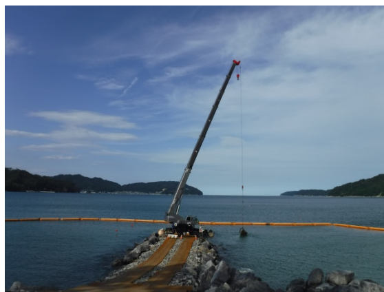
被覆石設置(水中)
