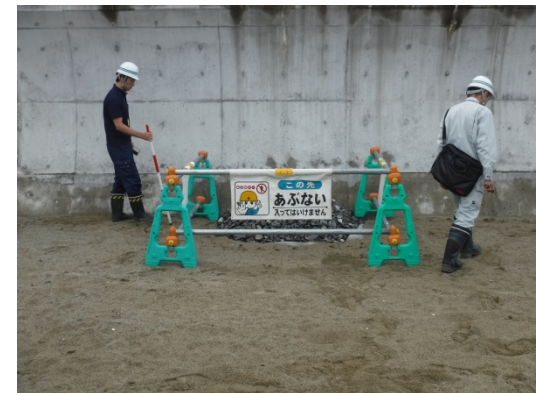
安全点検(横断暗渠)
