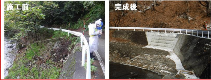
小焼巻の2工区
