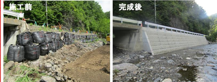
小焼巻の3工区
