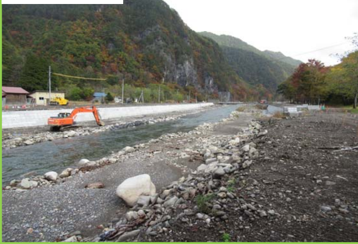
安家橋上流状況
