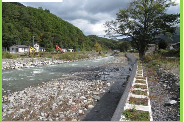
大正橋上流状況
