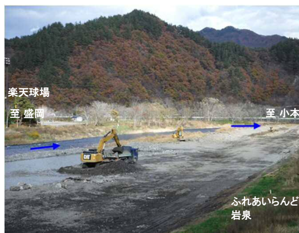
施工状況(H30.11月)
