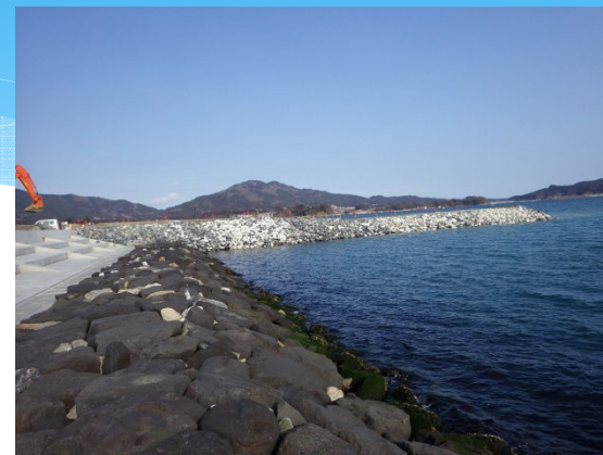
仮突堤①完成
