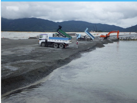
碎石投入状況
