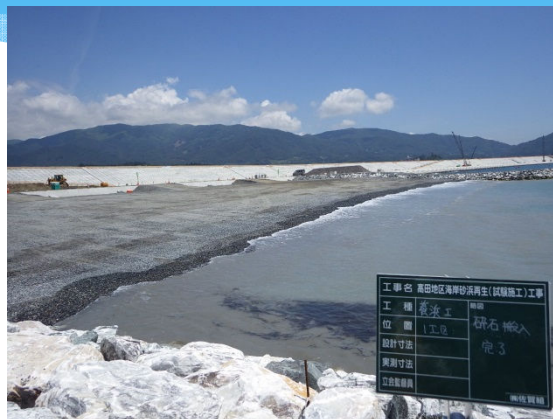
碎石投入完了
