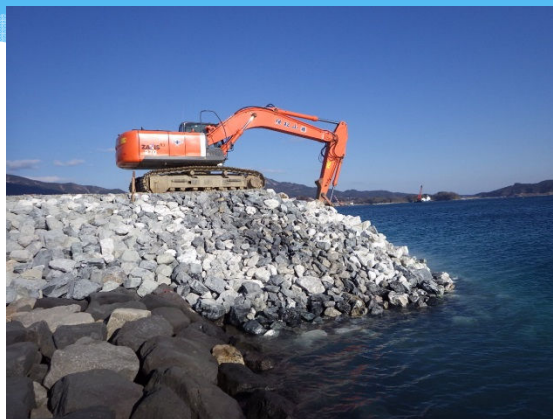
捨石投入状況
