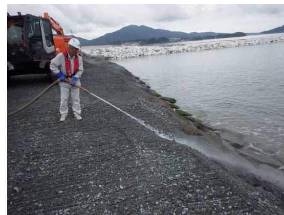
第1線堤被覆石 空隙充填②
