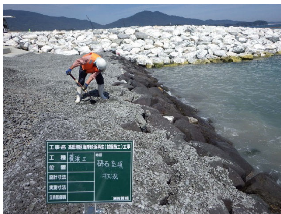
第1線堤被覆石 空隙充填①
