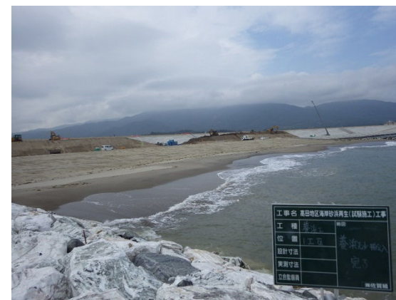
砂(第1層)投入完了
