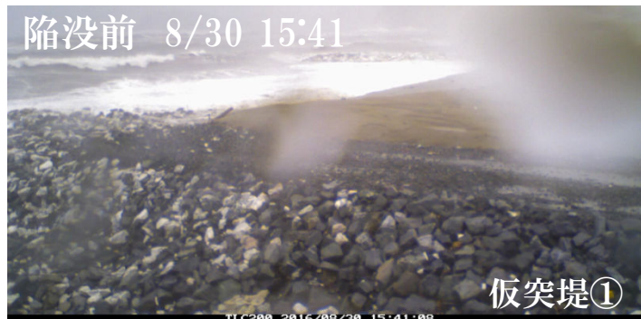
陥没穴発生時(カメラ1撮影)
