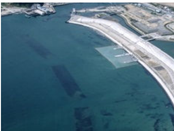
シルトフェンス設置状況
