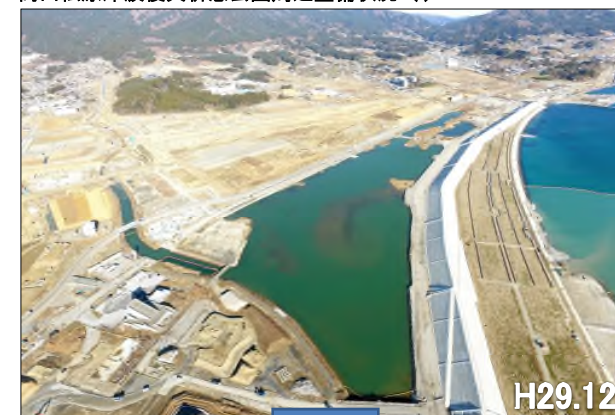
高田松原津波復興祈念公園周辺整備状況 (3)
