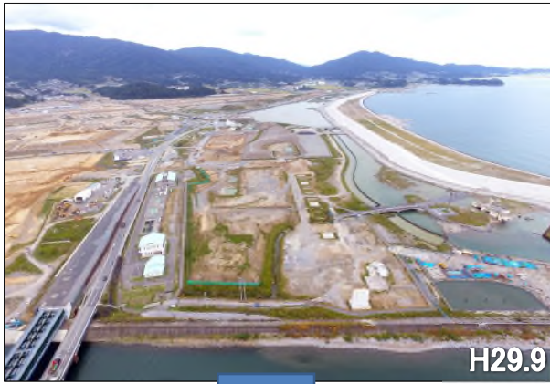
高田松原津波復興祈念公園周辺整備状況 (4)
