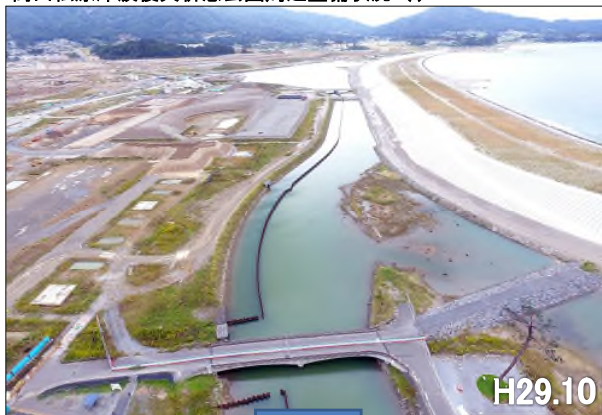
高田松原津波復興祈念公園周辺整備状況 (1)
