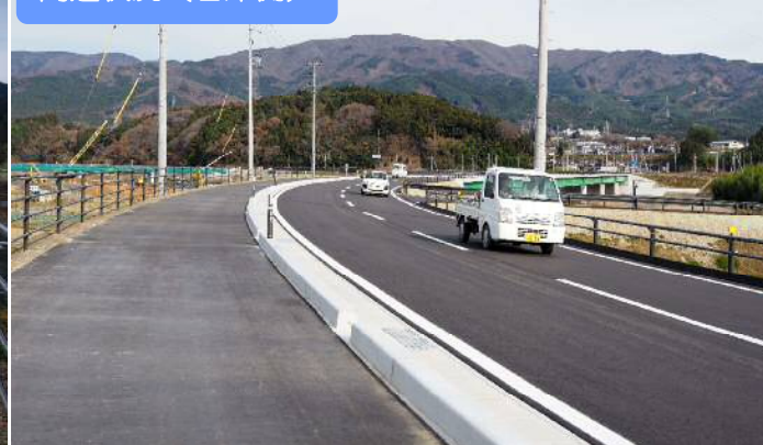
開通状況（右岸側）
