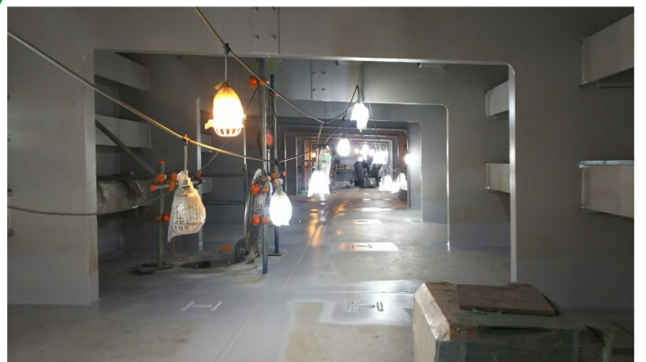
水門扉体内部の状況
