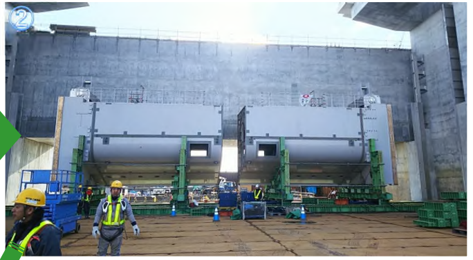
② 水門の両端ブロックを先に組み立てて、それぞれを右岸左岸の柱側に移動させます。
