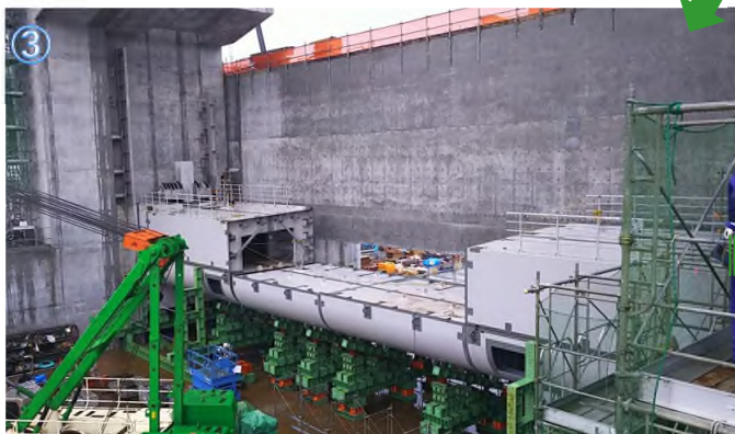
③ 両端に移動して空いた中央のスペースに残りのブロックを入れて組み立てます。
