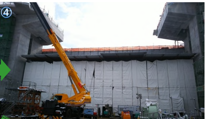
④ 両組立後、天候に左右されないようにシートで覆い、各ブロックのつなぎ目を溶接で接合します。
