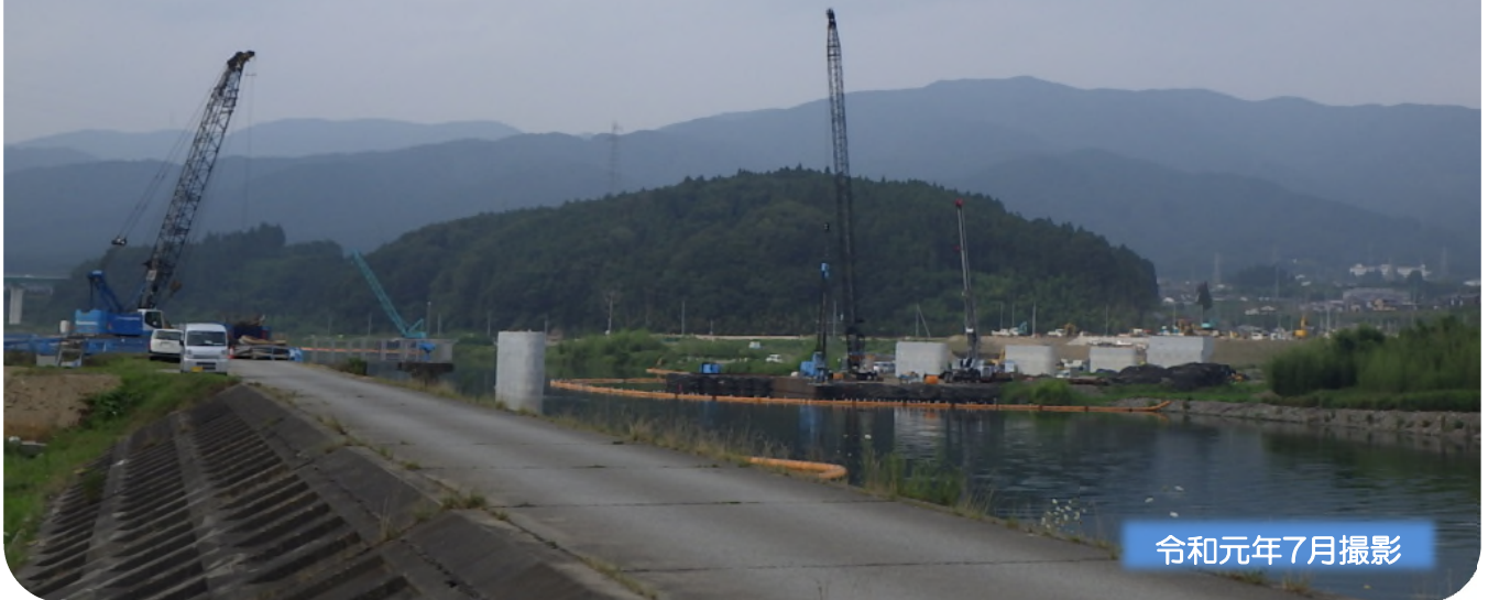
国道340号(仮称)今泉大橋 下部工工事
