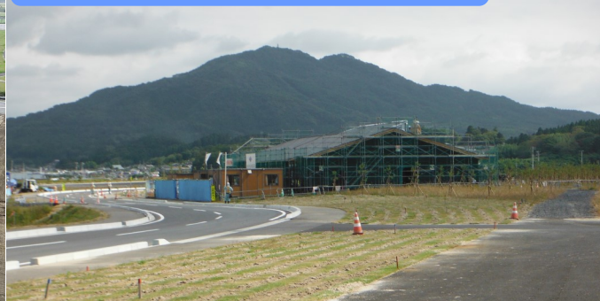
公園管理事務所建築状況（9月24日撮影）
