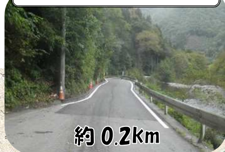
県道釜石住田線 中塚工区
