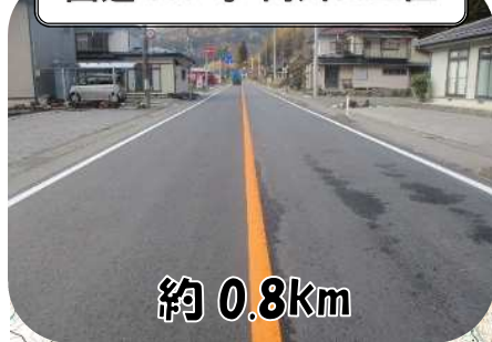
国道107号 向川口工区
