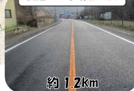
国道107号 赤畑工区
