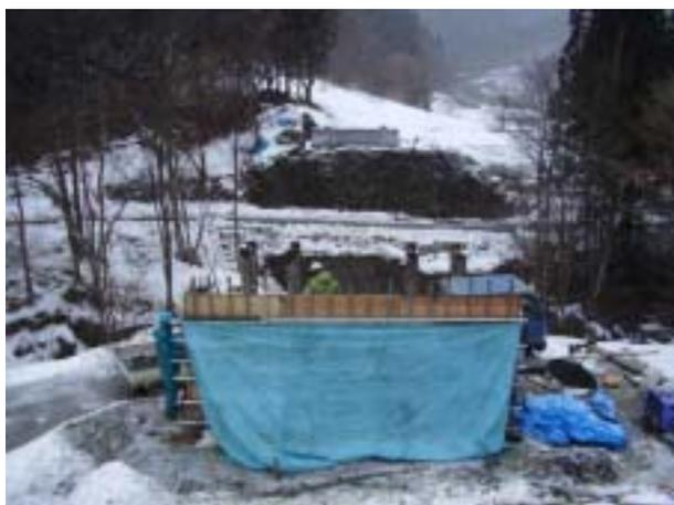
仮橋は、川の中での工事を不要とする構造にするなど、川の濁りや土砂の流出を発生させないように、細心の注意を払って工事を進めています。
