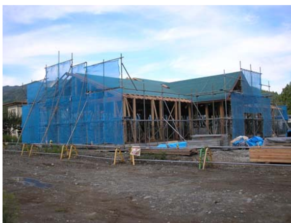
(事務所新築工事の様子)
