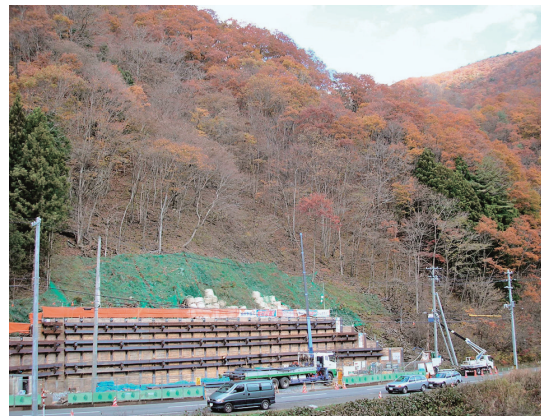
(左岸側P2橋脚の状況)
