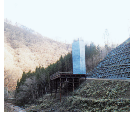
(右岸側P1橋脚の状況)
