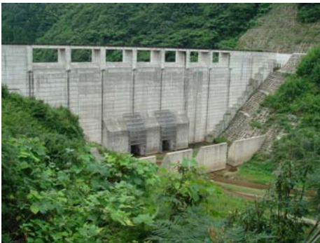
↑【流水型ダムの例】平成17年度完成の 島根県・益田川ダム（貯水池側）
