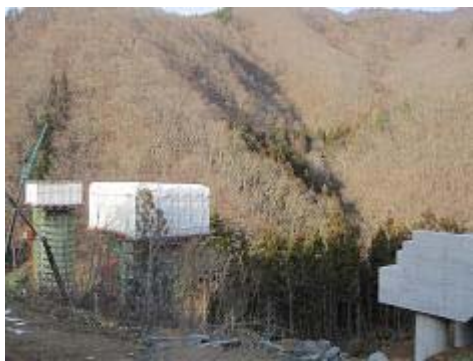
《二号橋梁の工事状況》
