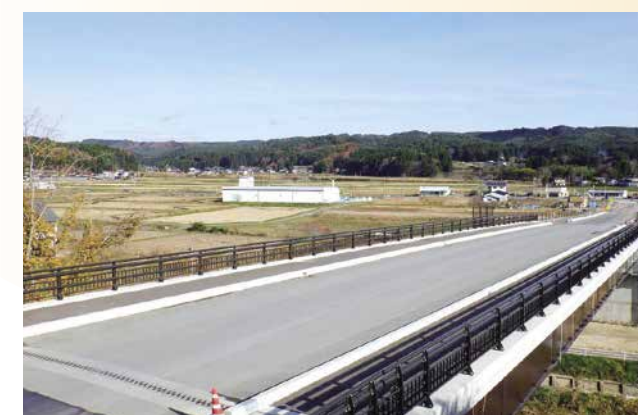
まもなく開通予定の主要地方道野田山形線
