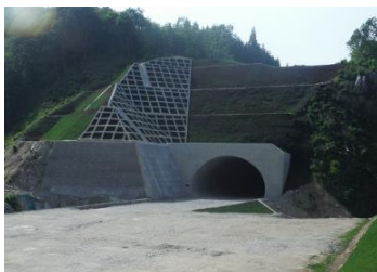
〔浜山トンネル〕
