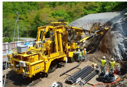
“掘削工事中の案内地区トンネル工事”
